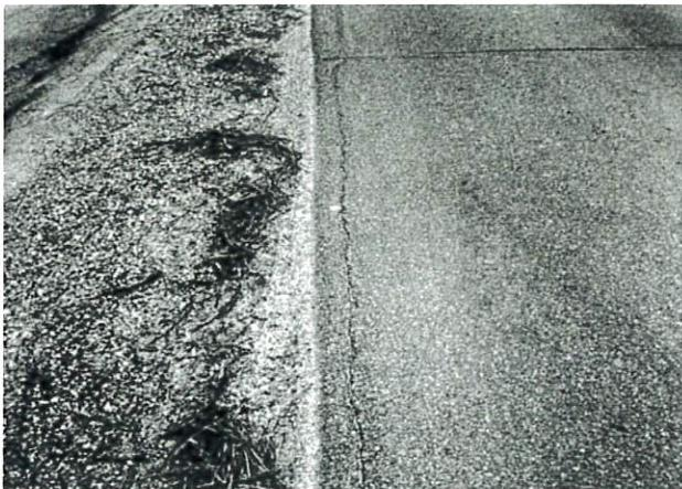
FIG. X1.19 Low-Severity Edge Cracking
